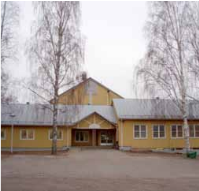
Nukarin koulu oli pilottikohteena Nurmijärven hankkeessa, jossa öljylämmitteisiä kiinteistöjä muutetaan maalämmöllä lämpiäviksi.
